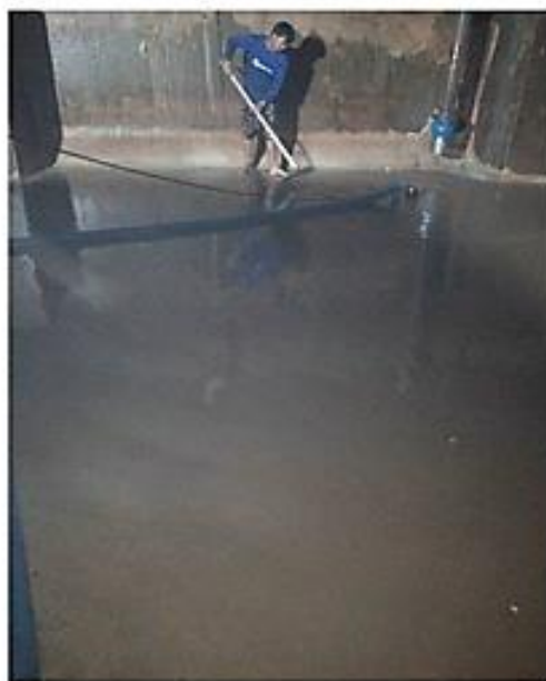
รูปภาพที่ 136 ภาพการทำความสะอาด ถังเก็บน้ำดี
