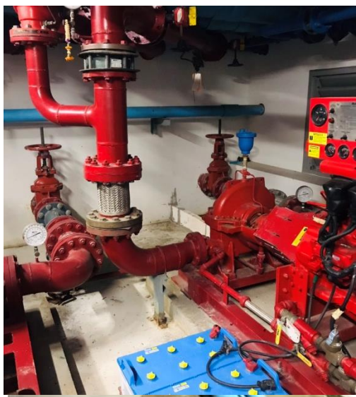
รูปภาพที่ 87 ภาพเครื่องสูบน้ำดับเพลิง (Fire Pump) ชนิดขับเคลื่อนด้วยเครื่องยนต์ ดีเซล
