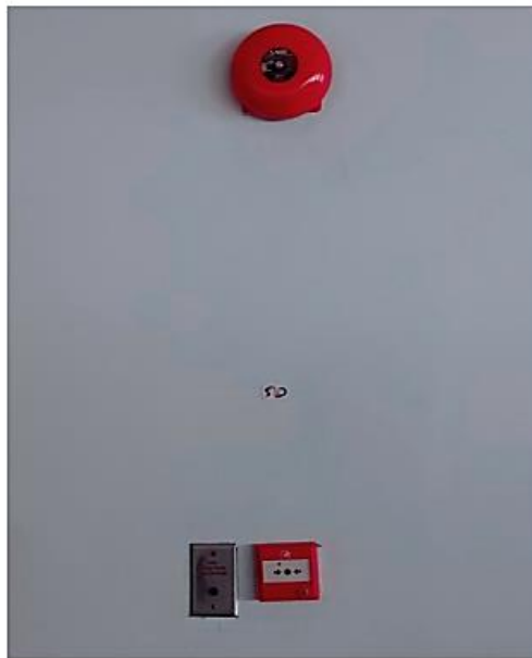
รูปภาพที่ 102 ภาพกริ่งสัญญาณเตือน อัคคีภัย
