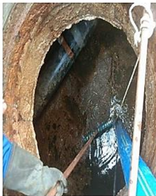
รูปภาพที่ 12 การสูบน้ำออก
