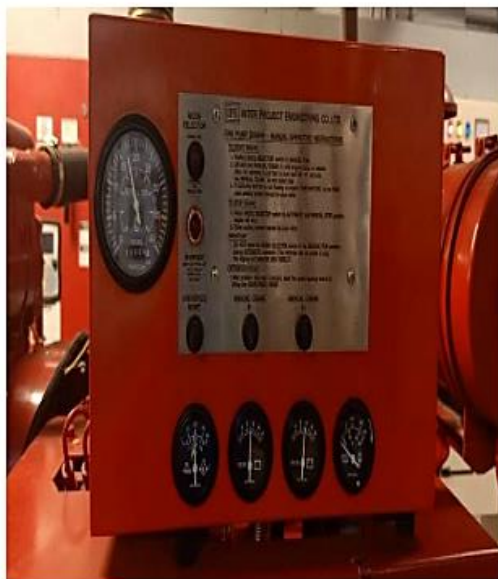
รูปภาพที่ 89 ภาพ เครื่องสูบน้ำดับเพลิง (Fire Pump) ชนิดขับเคลื่อนด้วย เครื่องยนต์ดีเซล
